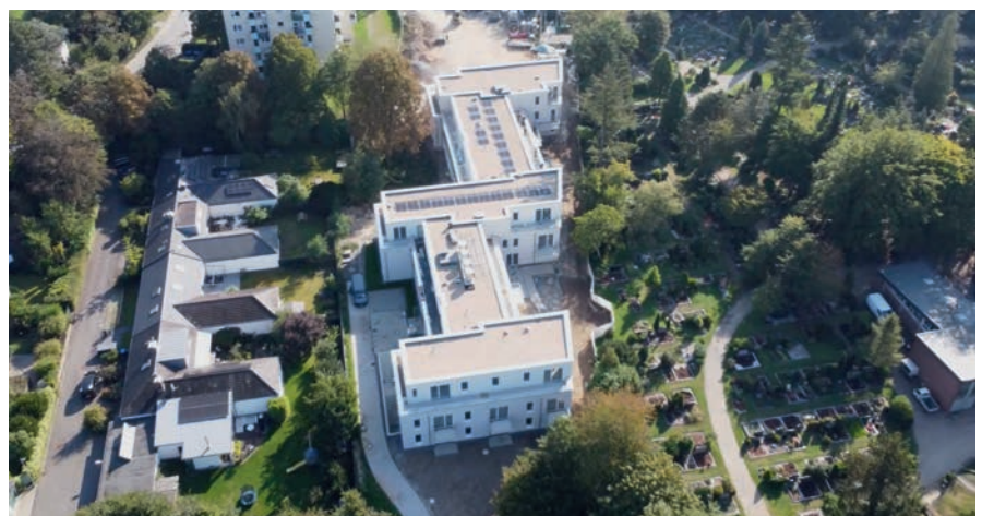
Ausgeklügelte Architektur: Erst aus der Vogelperspektive wird deutlich, wie optimal die 30 Wohnungen und 9 Apartments die gegebene Grundstücksfläche nutzen.
