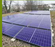
Neue PV-Anlage installiert
